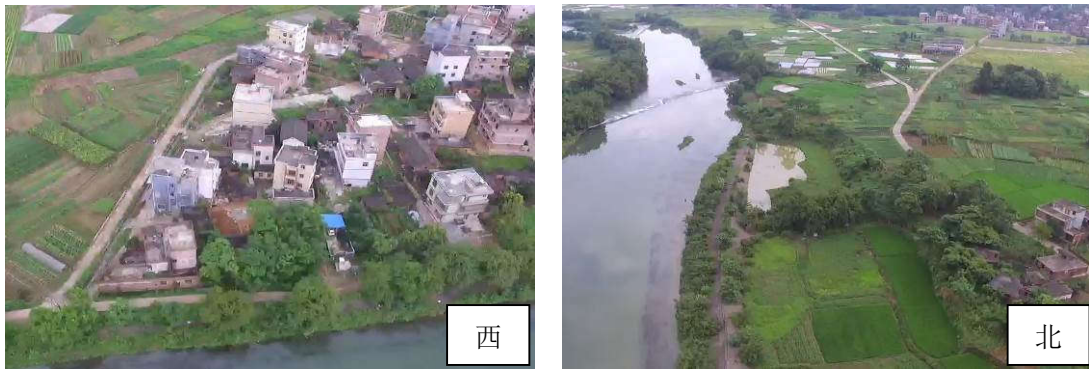
图 1-1 污水厂周边环境照片
