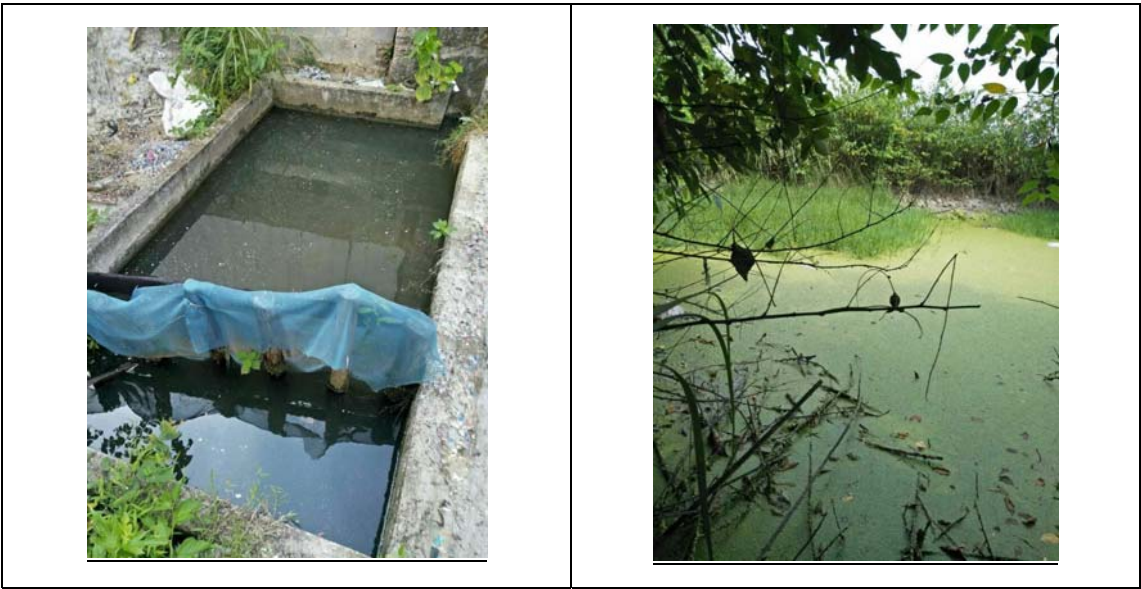
图 5-1 现有生活污水蓄水池及氧化塘
