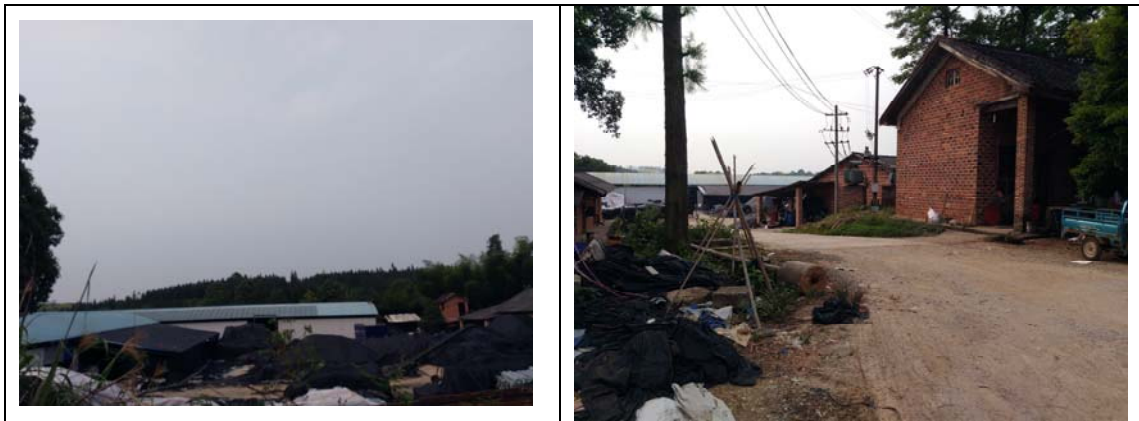
图 2-1 项目现场照片
